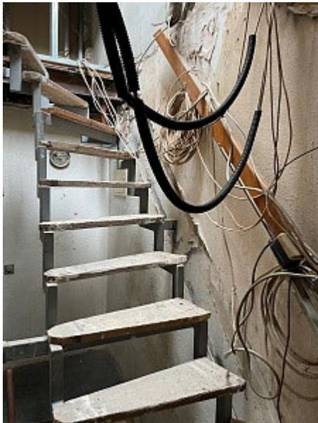
Die teilweise unisoliert von Decke und Wänden hängende Elektroinstallation stellt eine gravierende Unfallgefahr dar. Foto: Innenressort.
