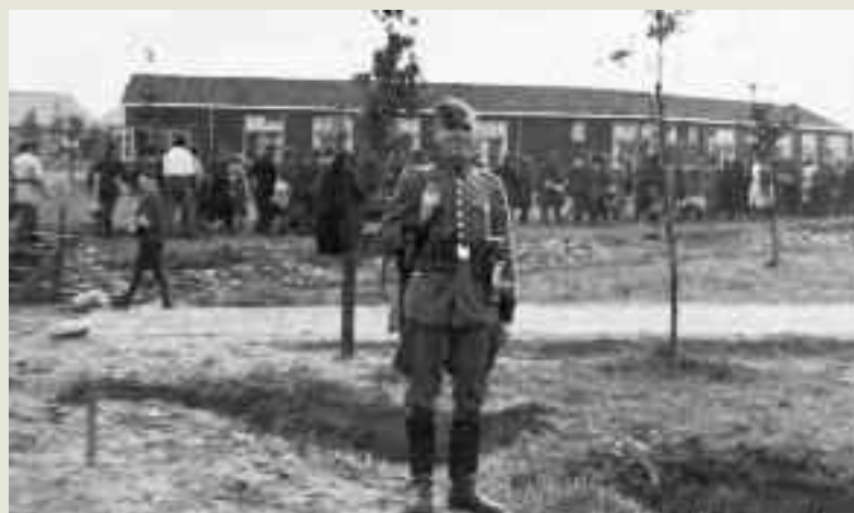
Oktober 1942. Das Lager Westerbork, Durchgangslager für die Deportation von Juden aus den Niederlanden in die Vernichtungslager im Osten. Wachposten: Angehöriger des Polizeibataillons 105. Sammlung Schneider
